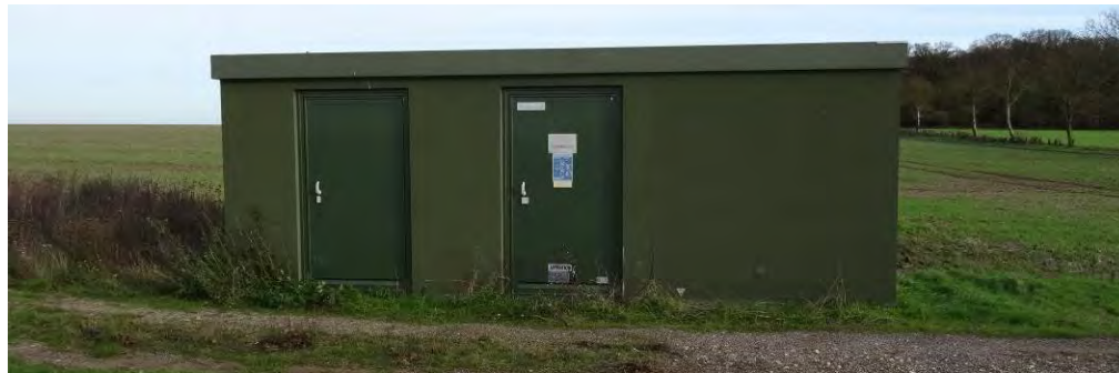
Illustration 25 : Exemple de poste de livraison avec peinture vert foncé
